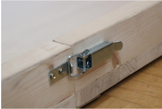
Klappscharnier unter der Grundplatte und Schnellspanner außen an den Banden (Schnittlinie links)
