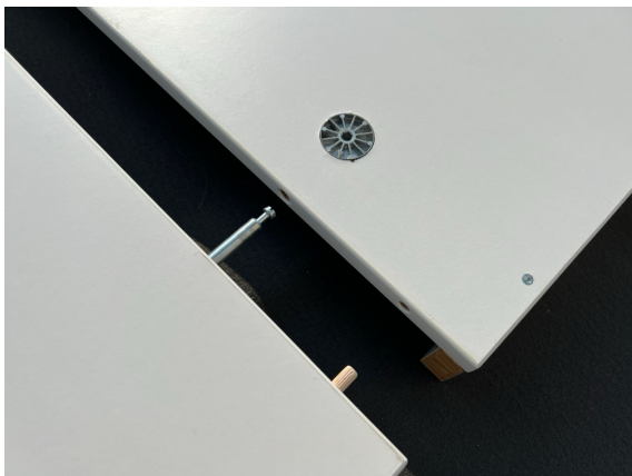
Detail Unterseite Exzenterbeschlag
